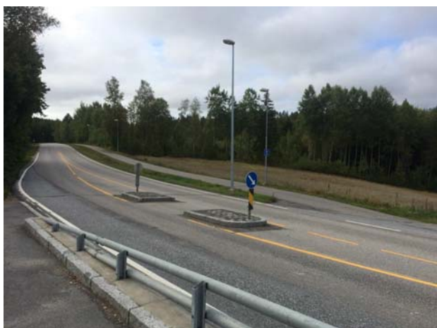
Fig 34. Bør merkes som fotgjengerovergang
