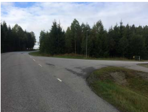
Figur 18. Vikeplikts-skilting mangler i krysset.
